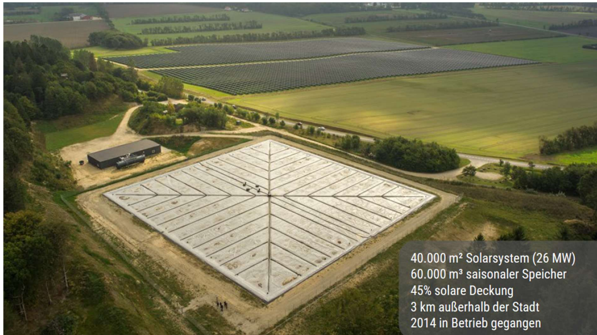
Abbildung 16: Beispielhafte Solarthermie-Freiflächenanlage mit saisonalem Speicher 9
